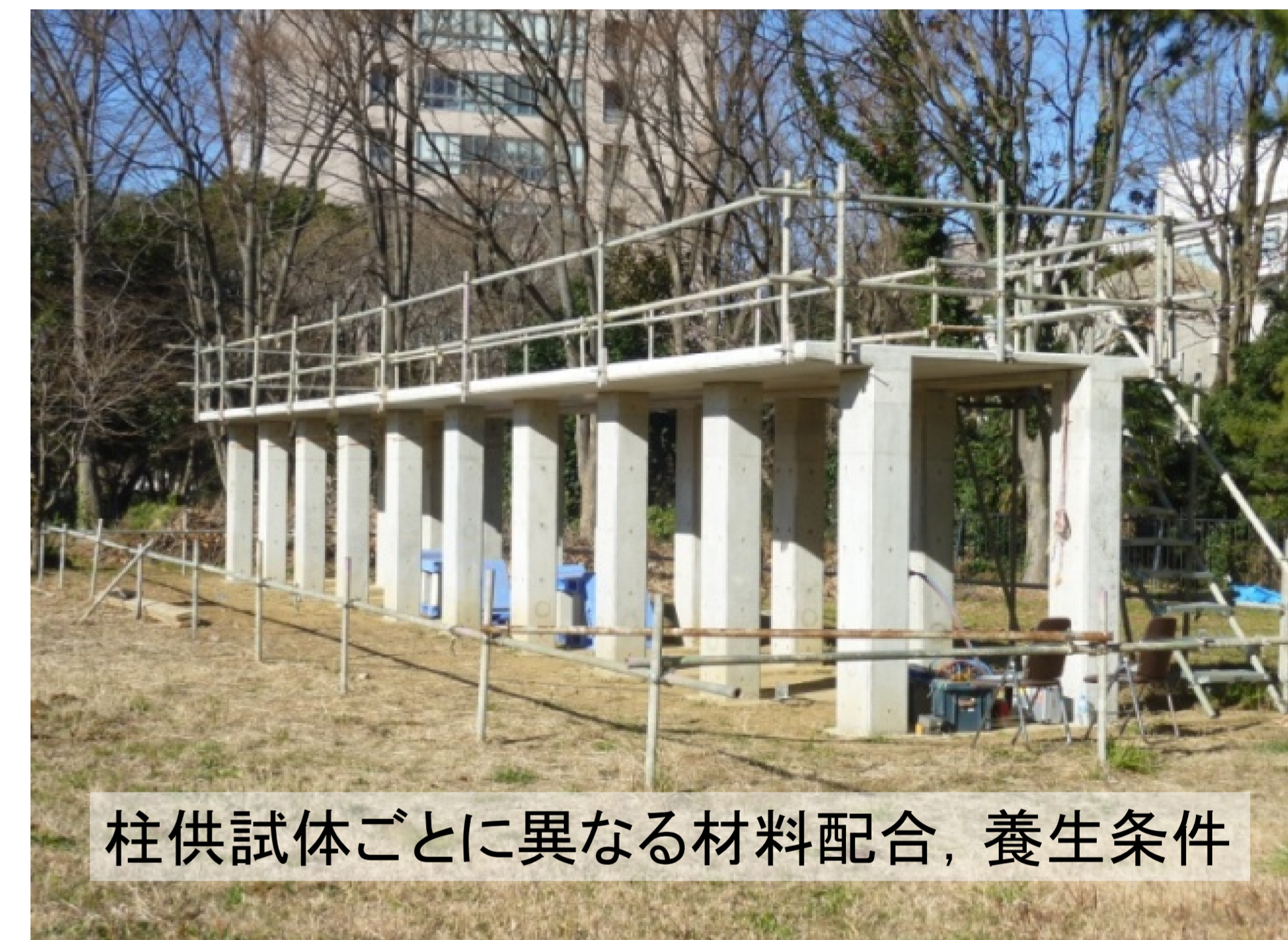
中規模RCラーメン模擬高架橋
